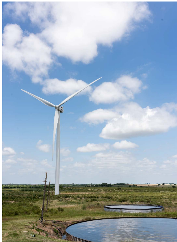
Molinos de viento y reservas de agua de lluvia - Engraw
